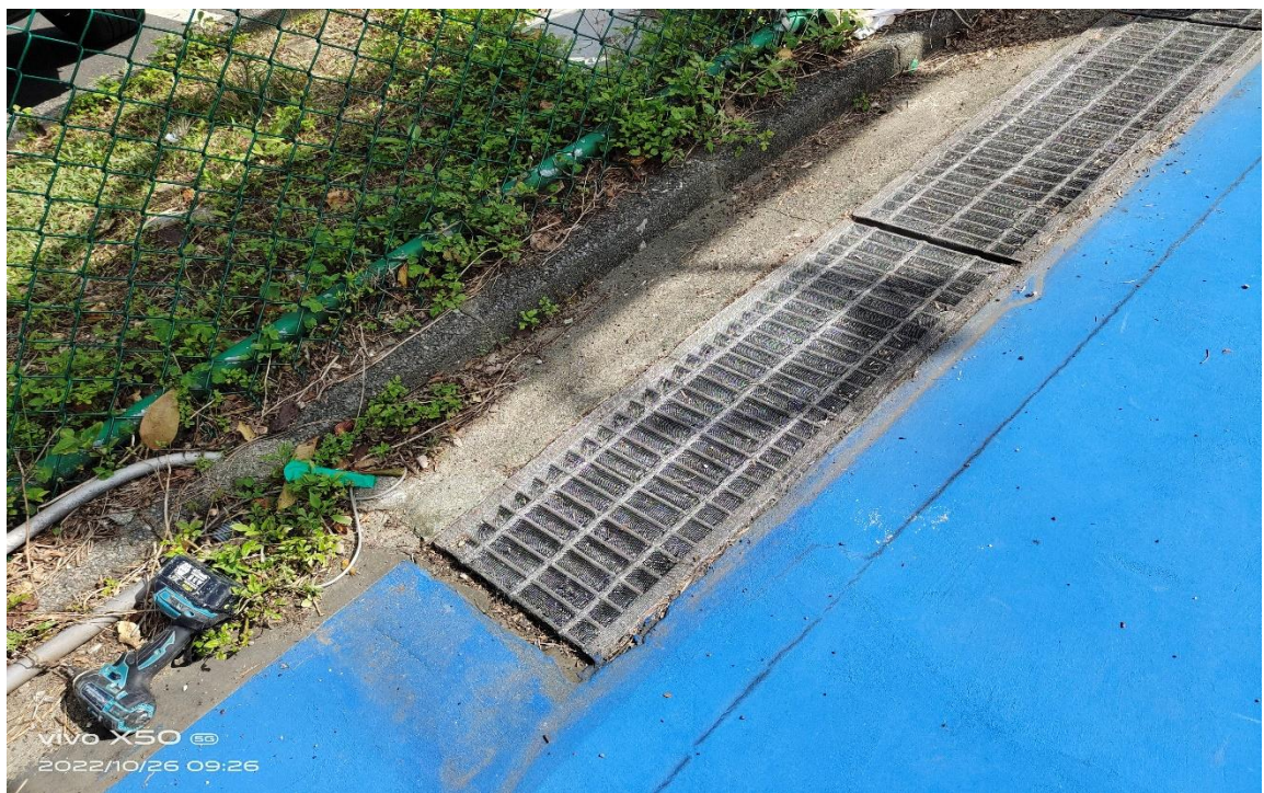
永茂室內裝修工程行（籃球場水溝蓋整修）施工照片 施工前
