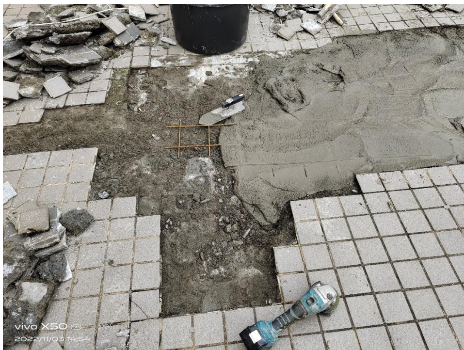
永茂室內裝修工程行（游泳池前地坪整修）施工照片 施工前
