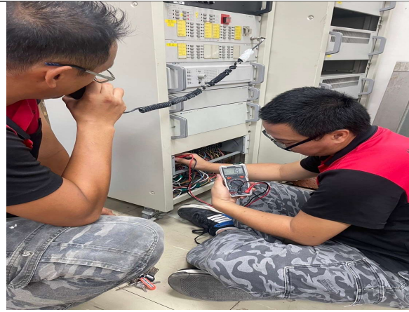
緊急廣播喇叭迴路與幹線連結施工中-2
