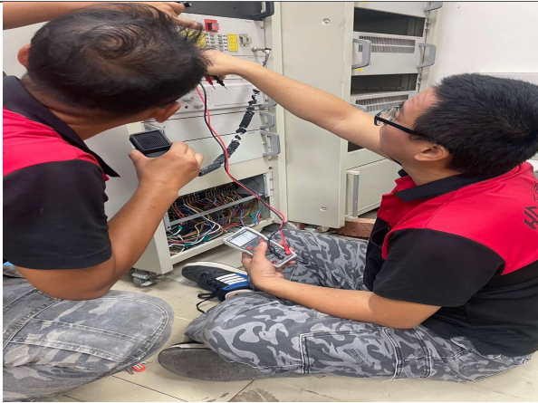
緊急廣播喇叭迴路與幹線連結施工中-1
