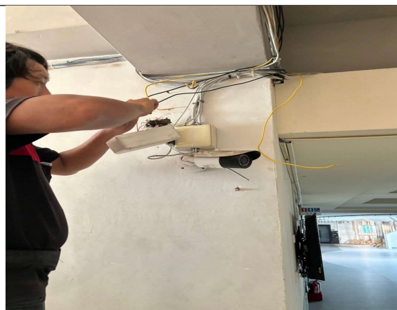
緊急廣播喇叭回路配置施工中-2
