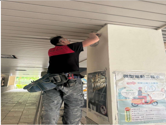
緊急廣播喇叭迴路與幹線連結施工中-1
