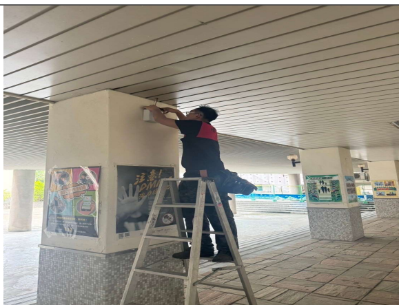
緊急廣播喇叭回路配置施工中-3
