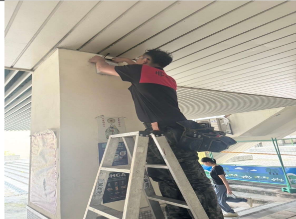
緊急廣播喇叭迴路與幹線連結施工中-2
