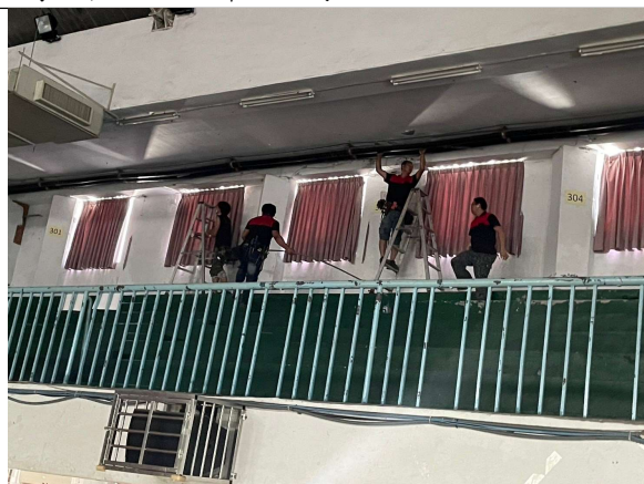
對照式探測器電源及訊號回路配置施工中
