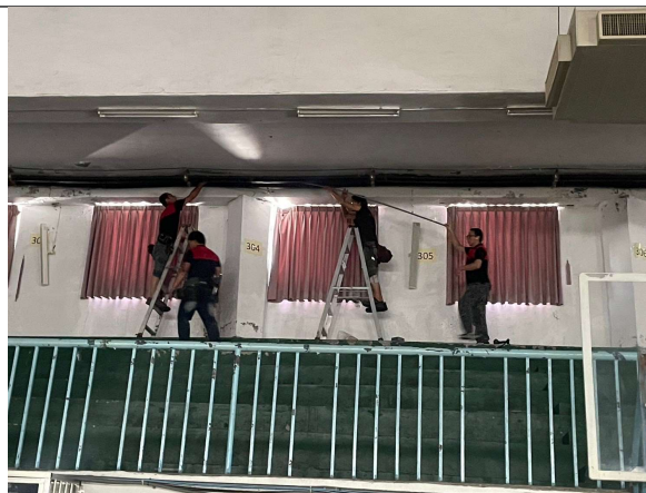
對照式探測器電源及訊號回路配置施工中
