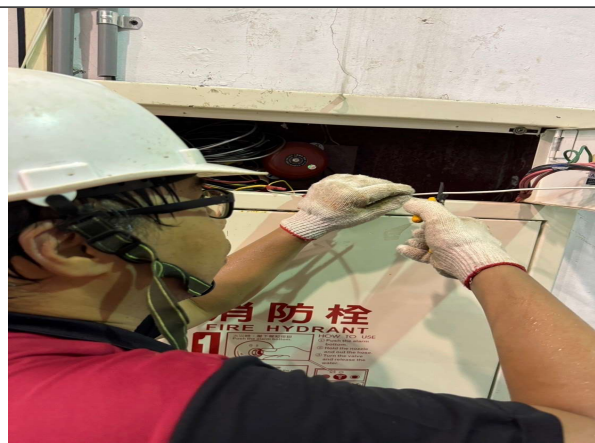
對照式探測器安裝調整施工
