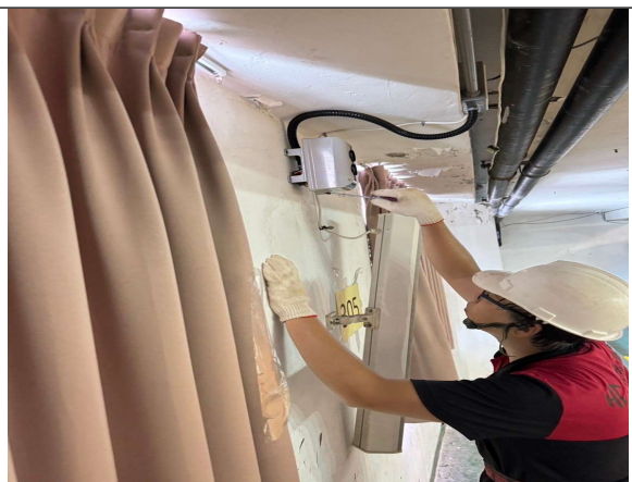
對照式探測器電源及訊號回路配置施工中
