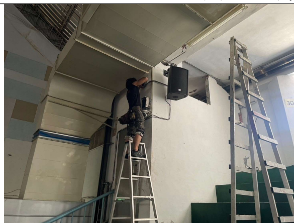
對照式探測器電源及訊號回路配置施工中
