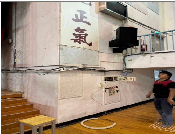
侷限型偵煙探測器訊號回路配置施工中
