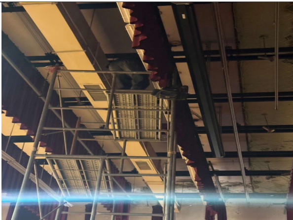
侷限型偵煙探測器訊號回路配置施工中
