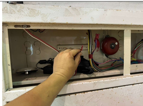
侷限型偵煙探測器訊號回路配置施工中
