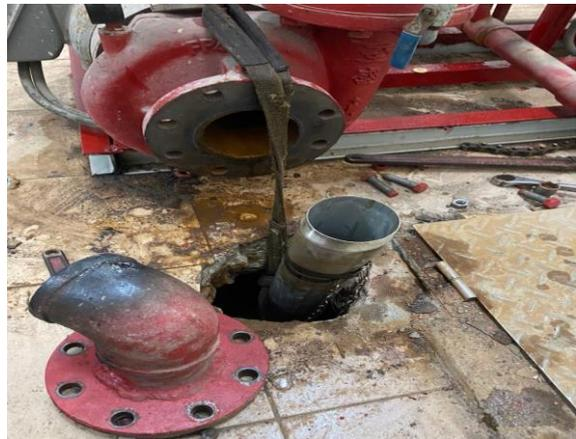
消防機組底閥管路安裝施工中
