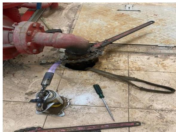
消防機組底閥管路拆解施工中
