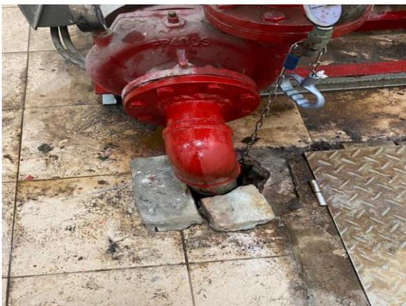
消防機組底閥管路不鏽鋼更換施工完成
