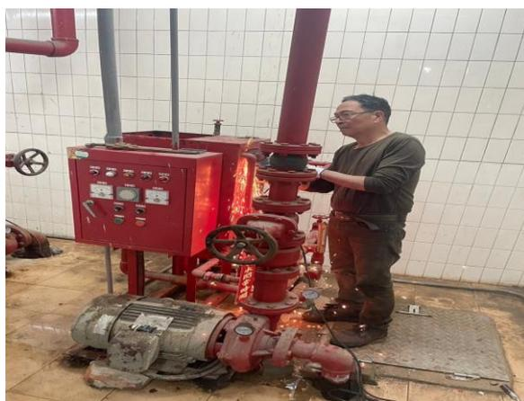
消防機組呼水槽更換施工中
