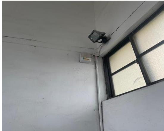
緊急照明燈更換施工完成
