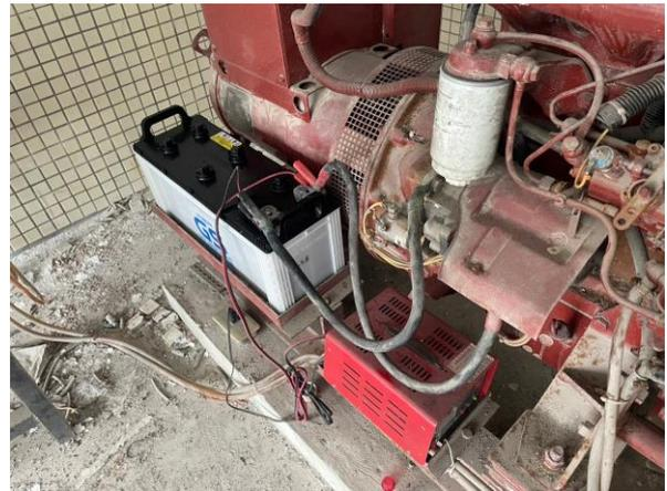
發電機啟動電瓶更換施工完成
