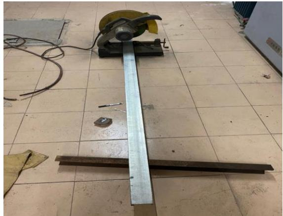
機組底座槽鐵切割施工中
