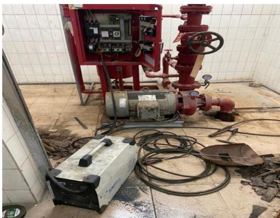
機組底座槽鐵焊接施工中
