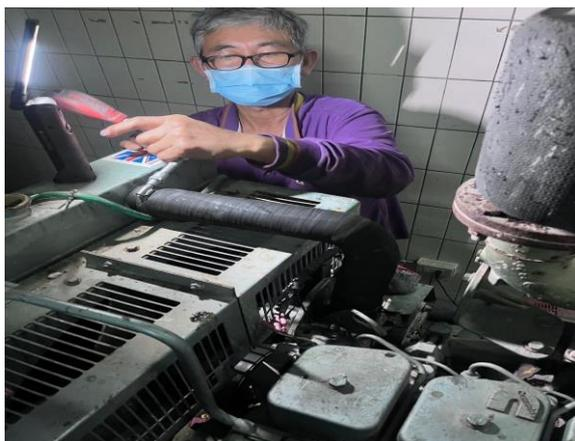
發電機組冷卻管路更換施工中
