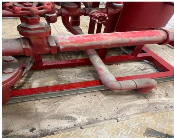
消防機組底座除鏽更換完成
