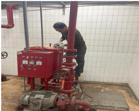
消防機組呼水槽管路安裝施工中
