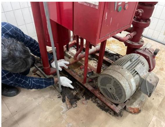
消防機組底座除鏽施工中
