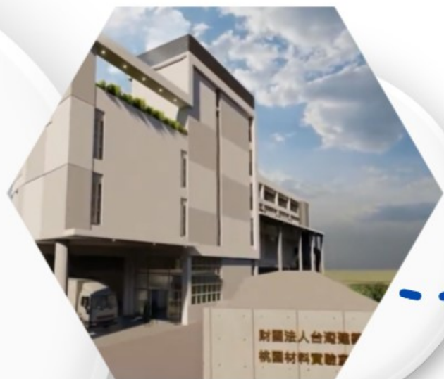
台灣建築中心 桃園材料實驗室
