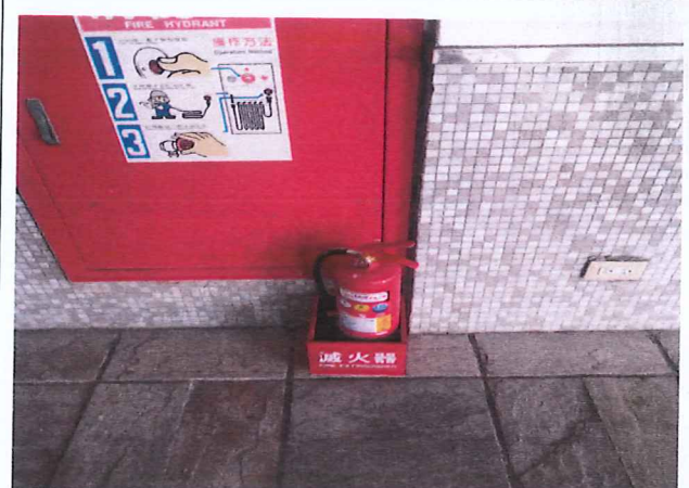
滅火器更換放置完成-1
