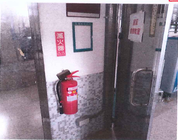
滅火器更換放置完成-2
