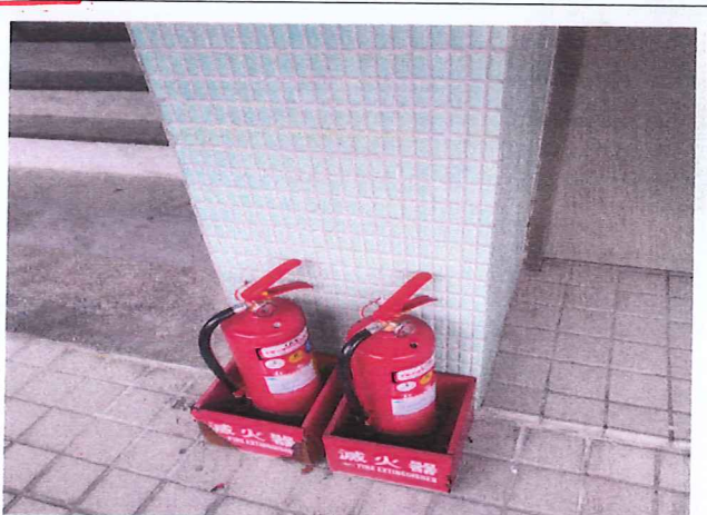
滅火器更換放置完成-3
