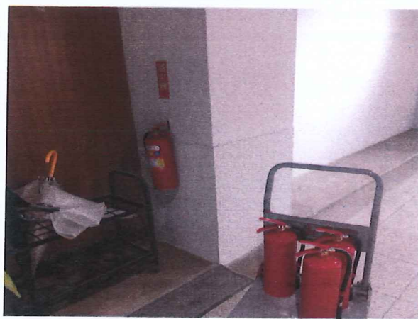
滅火器更換放置施工中
