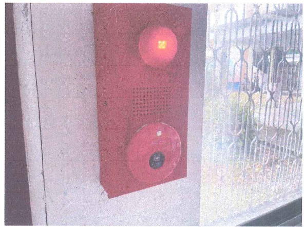
火災報知機更換施工完成
