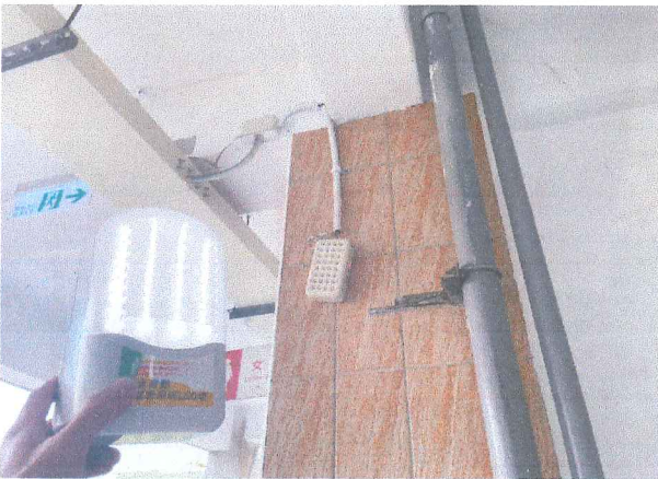
緊急照明燈更換施工中
