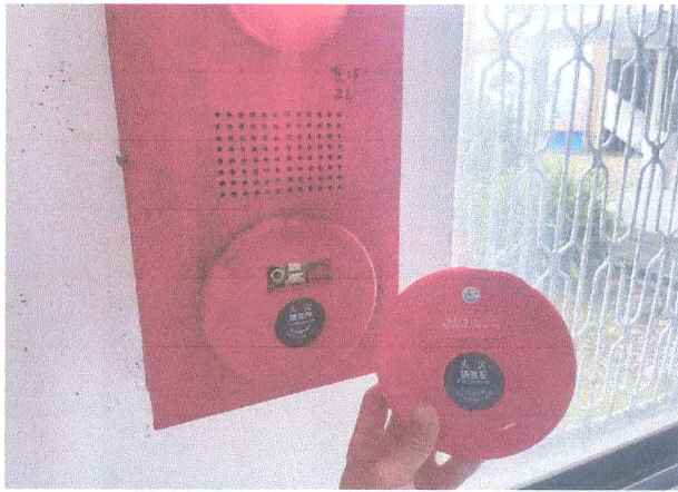
火災報知機更換施工中
