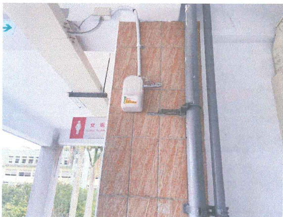
緊急照明燈更換施工完成
