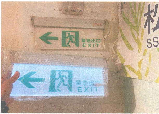
避難方向指示燈更換施工中
