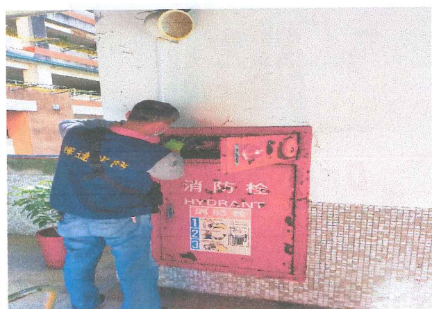
消防栓箱面板更換施工中
