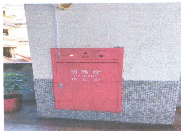
消防栓箱不鏽鋼面板更換施工完成
