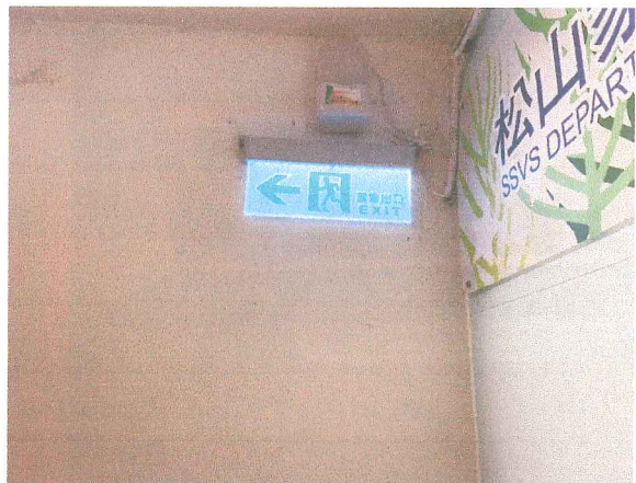
避難方向指示燈更換施工完成
