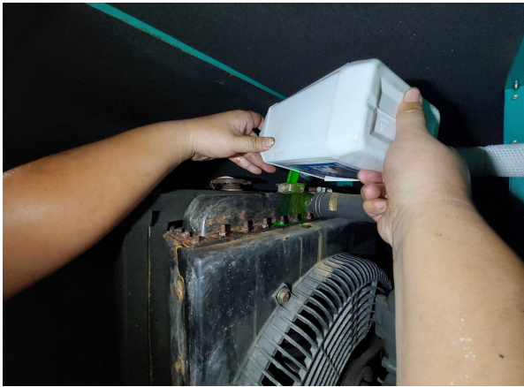
冷卻水箱精添加施工
