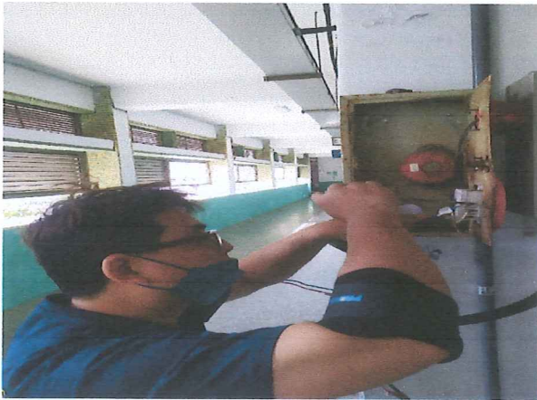
火警標示燈回路查修施工中
