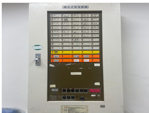
火警回路查修施工完成(5F-1)
