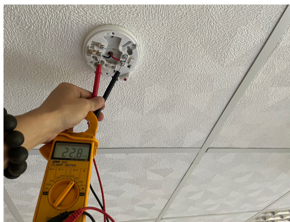
火警回路查修施工中(5F-1)
