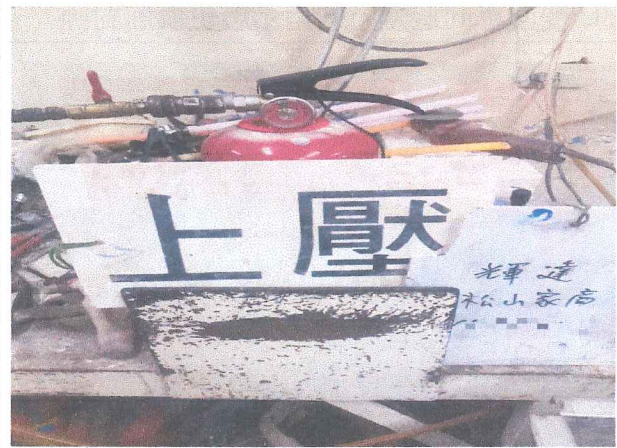
滅火器性能檢查施工-2
