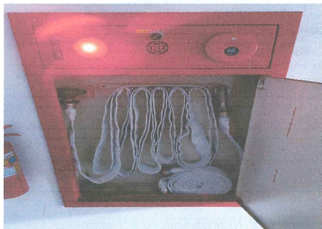
1 1/2"消防水帶更換完成-1
