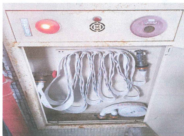
1 1/2"消防水帶更換完成-2
