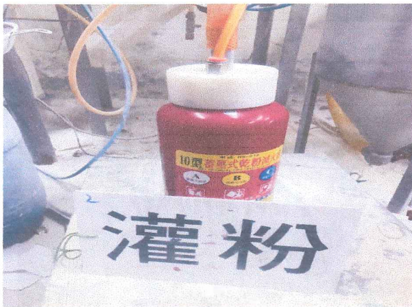
滅火器性能檢查施工-1
