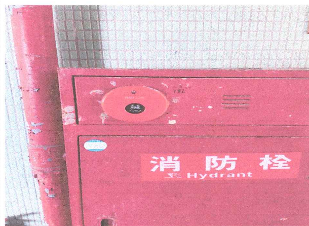
火災報知機新品更換完成
