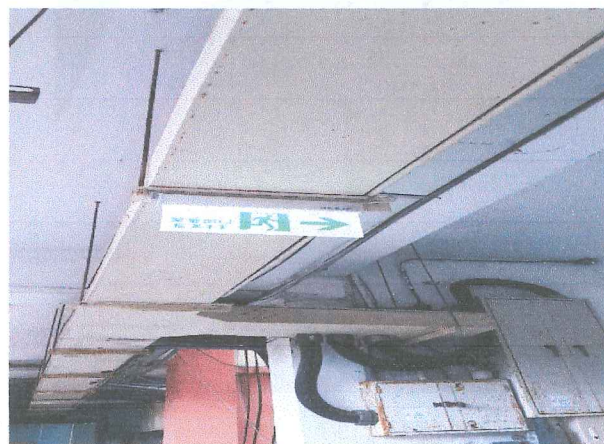
LED 雙面單向避難方向指示燈更換完成
