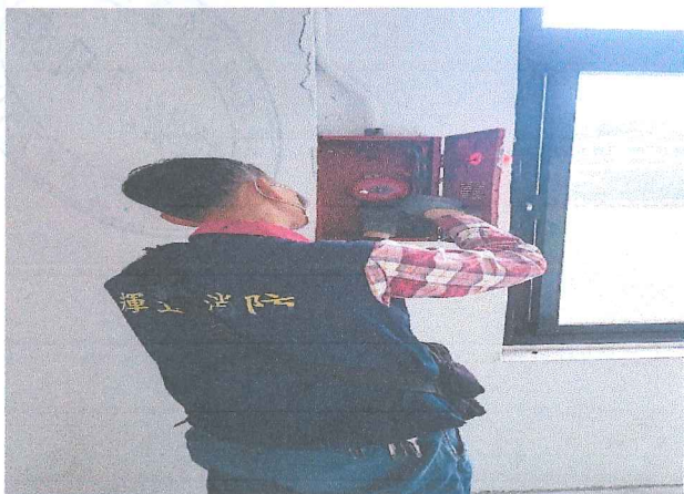
火警警鈴更換施工中
