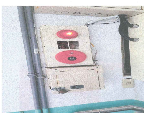
火災報知機更換施工完成
