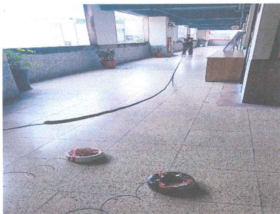
火警警鈴回路查修配置施工中
