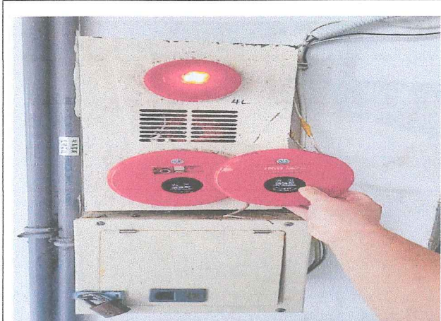
火災報知機更換施工中
