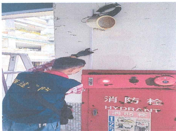
火警警鈴回路查修施工中
