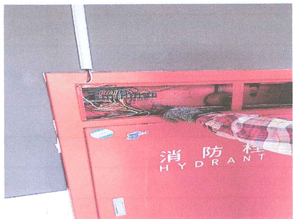
火警警鈴回路連結施工中
