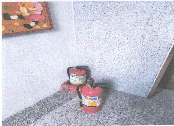
滅火器更換施工前對照
