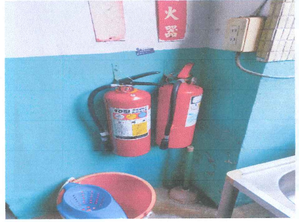
滅火器更換施工完成
