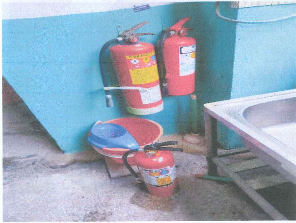
滅火器更換施工前對照
